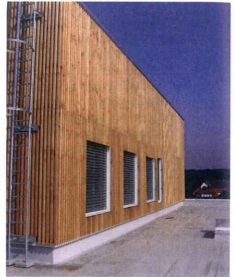
Die verschiedenen Dachebenen werden unterschiedlich behandelt. Neben einem schlichten, begehbaren Flachdach legte IBB eine extensive Begrünung auf dem Silodach an. Eine intensive Begrünung auf dem Dach des Büros soll folgen.
