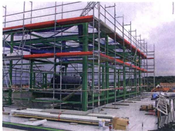
Das Stahlgerüst bildet das Trägerskelett für die Komponenten der Kraftwerksanlage. Schon allein der 51 Tonnen schwere Thermoölerhitzer benötigt eigene Stützen.
