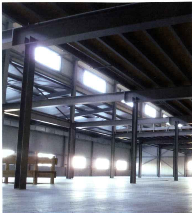
Da der Untergrund auf dem Baugelände eine geringe Tragfähigkeit aufweist, mussten zunächst Bodenverbesserungsmaßnahmen durchgeführt werden. Außerdem wurden die Fundamente für tragende Stützen und Wände bis zu zwei Meter tief gegründet.
