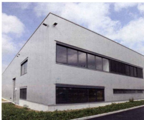
Zehn Monate Bauzeit: Die Stahlbauer montierten an einem Hallenteil bereits Dach und Fassade, während an anderer Stelle erst das Stahlgerüst errichtet wurde. | Foto: IBB
