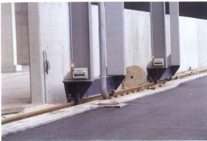
Die zwei beweglichen Hallensegmente sind auf Schienen verfahrbar. | Fotos: IBB
