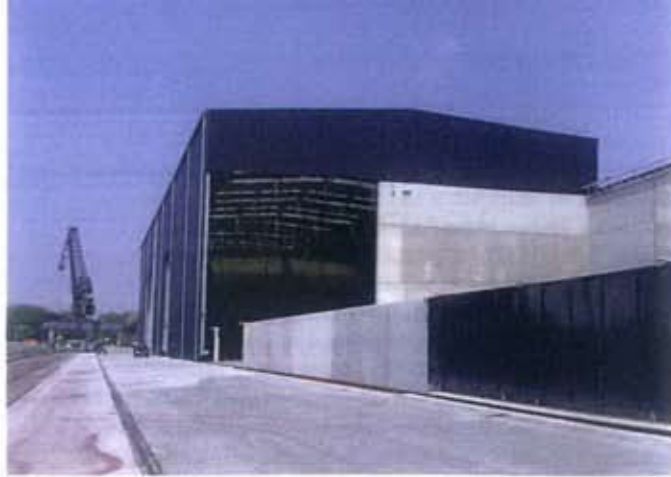
Bild 2. Jedes Hallensegment ist knapp 33 m breit und ca. 21 m hoch – für den Bau wurde verzinkter Stahl verwendet, insgesamt 480 t
