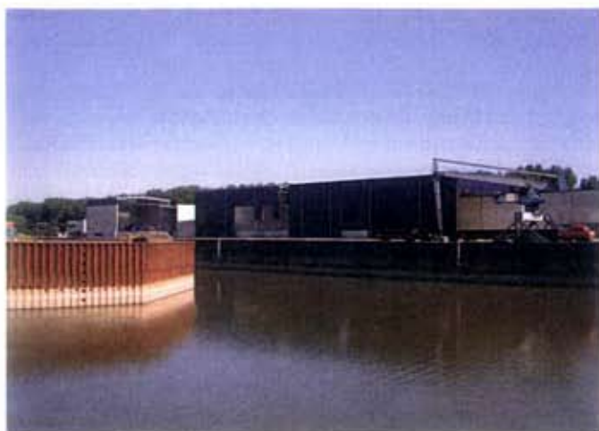
Bild 1. Um das Gelände des Metall-Recyclingunternehmens RuP am Düsseldorf-Wirtschaftshafen zu überdachen und dennoch die Verladeflexibilität zu erhalten, entwickelten die Stahlbauer von IBB Bönningheim eine mehrteilige Halle mit zwei verfahrenbaren Abschnitten
